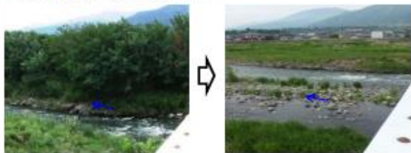
塩川 伐木 L=1,500m A=37,000m 2 (写真は韮崎市岩下地内 更科橋下流)
