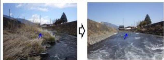
楡川 浚渫 L=720m V=360m 3 (写真は富士吉田市下吉田地内 新焼橋下流)
