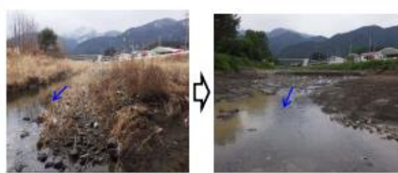
船山川 浚渫 L=340m V=8,400m 3 (写真は南部町南部地内 新船山川橋上流)
