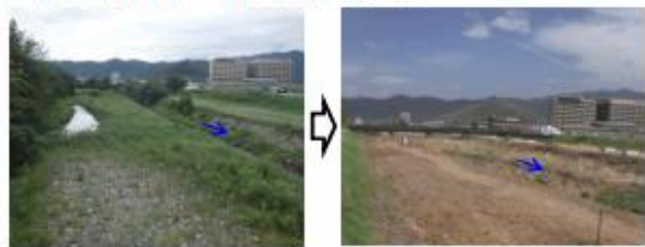
寛川 伐木 L=3,000m A=27,000m 2 (写真は甲府市下飯田一丁目地内 長松寺橋上流)
