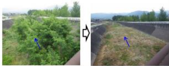
俣川 伐木 L=440m A=5,800m 2 (写真は南アルプス市川上地内 北落合橋下流)
