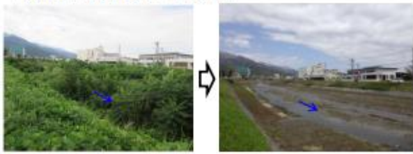
戸川 伐木 L=2,800m A=78,400m 2 (写真は富士川町最勝寺地内 戸川橋上流)
